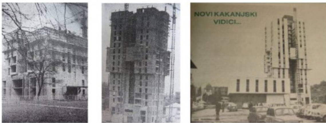
Slika 1. Prikaz izgradnje solitera
